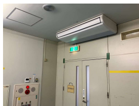
岩手工場 製造エリア 空調機更新
